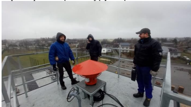
Druhowie tuż po zakończeniu montażu syreny alarmowej po kapitalnym remoncie.
