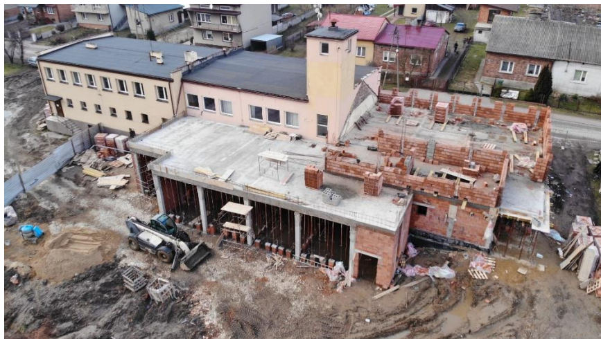
Fotografia przedstawiająca zakres prac budowlanych – wznoszące się mury budynku
