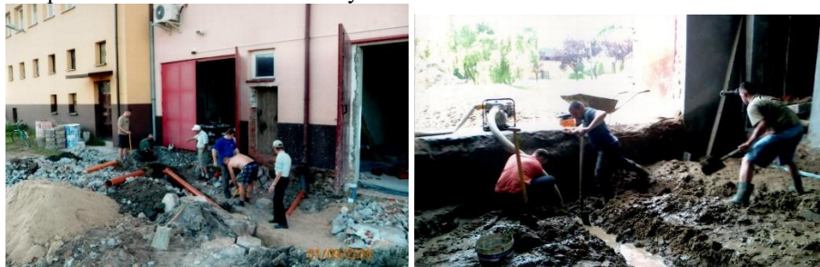
Fotografie przedstawiające niektóre wykonywane prace
